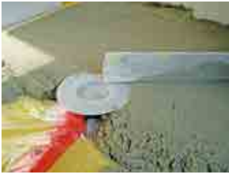
1. Estrich ausgießen und an dem Bauschutz des Ablaufes im Gefälle abziehen
