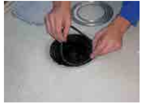
3. Bauschutz entfernen und Dichtflansch reinigen, Dichtring in die Ringnut des Dichtflansches einlegen
