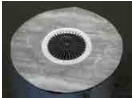
2. Voranstrich auf die Rohdecke einbringen
