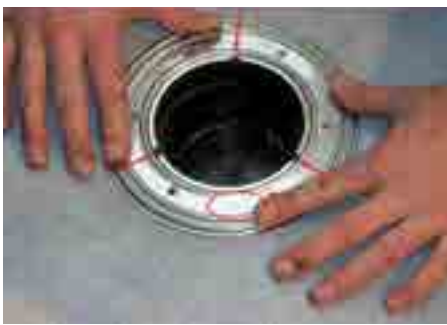
4. Dichtfolie über den Dichtflansch legen und Edelstahlring einpassen, Oberseite des Edelstahlringes beachten!
