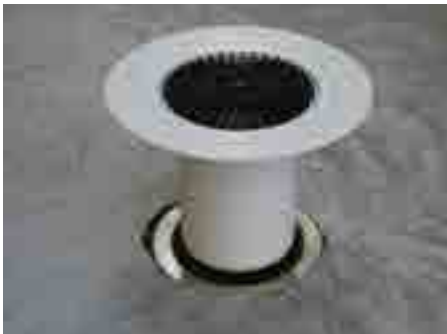
7. Aufstockelement HL350.0 auf Entwässerungsring HL160 aufsetzen
