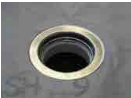
10. Filtervlies mithilfe des tellerförmigen Edelstahlrings auf den Dichtflansch klemmen
