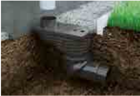
1. Regensinkkasten positionieren
