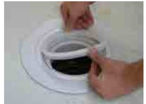
9. Transparenten Kunststoffring in die vorgesehene Ringnut des Dichtflansches einsetzen
