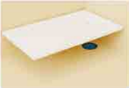
13. Duschtasse auf den Estrich versetzen
