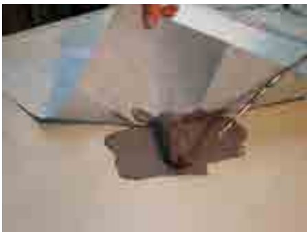
7. Verbundabdichtung vollflächig unter die Folie auftragen
