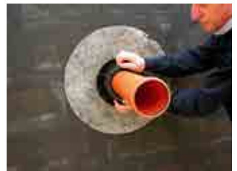
6. Sicherheitsmutter festziehen
