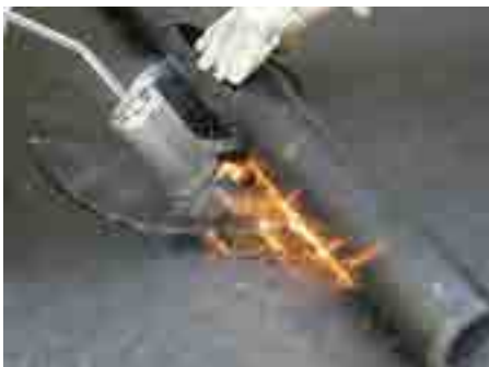
4. Zweite Bitumenlage mit Bitumenkragen des Ablaufs verbinden
