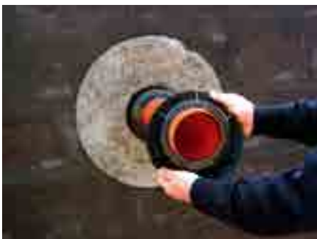
4. Sicherheitsmutter aufschrauben
