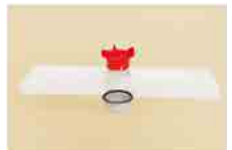
12. Ablaufventil in die Öffnung der Duschtasse einsetzen und mittels Montageschlüssel/Bauschutz mit der Gegenmutter so fest verschrauben, dass die Dichtung der Gegenmutter streng auf der Unterseite der Duschtasse sitzt (Dichtheit!!)
