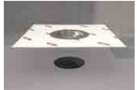
6. Abdichtgarnitur in den Ablauf einsetzen.
