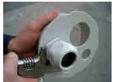
3. Verschraubungen und Rohrdurchführung verbinden, Verschraubungen festziehen
