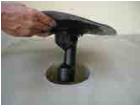
1. Ablaufkörper mit Bauschutz in den Deckendurchbruch einlegen
