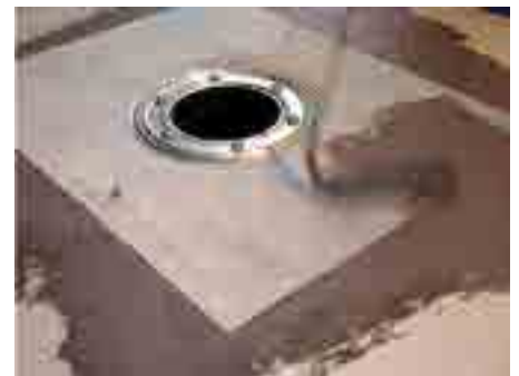
9. Verbundabdichtung vollflächig im gesamten Nassbereich auftragen
