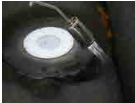
2. Werkseitigen Bitumenkragen des Abflaus mit der bauseitigen Bitumenbahn verschweißen
