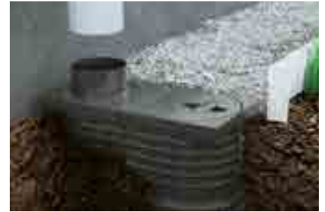
3. Regenfallrohr anschließen
