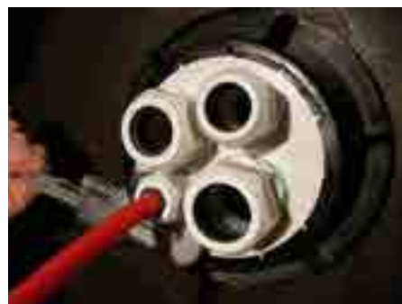
5. Leitungen/Rohre durchführen, Lagepositionierung festlegen, Klemmmutter der Durchgangverschraubungen festziehen
