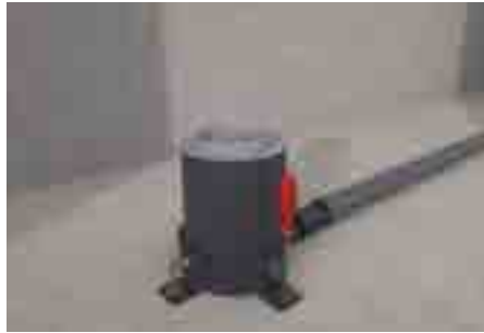
2. Löcher Bohren und den Ablaufkörper mittels Befestigungswinkeln und Schrauben an die Rohdecke fixieren.
