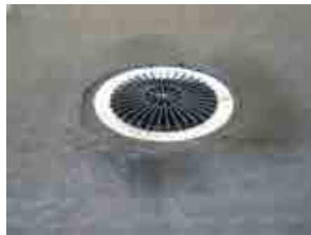
5. Fachgerechte Einbindung des Ablaufes in zweilagige Bitumenabdichtung
