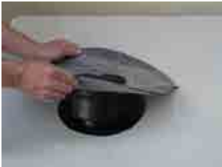
1. Kernbohrung erstellen mit Ø 255 mm, Ablauf HL62H in die Decke einsetzen
