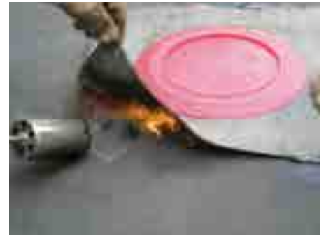
3. Bitumenkragen des Ablaufes auf die erste Bitumenlage flämmen
