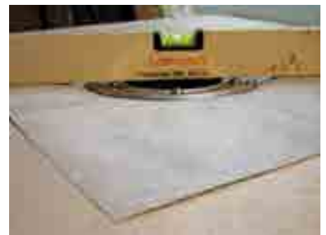
6. Die Dichtgarnitur liegt unterhalb der Estrich-Oberkante
